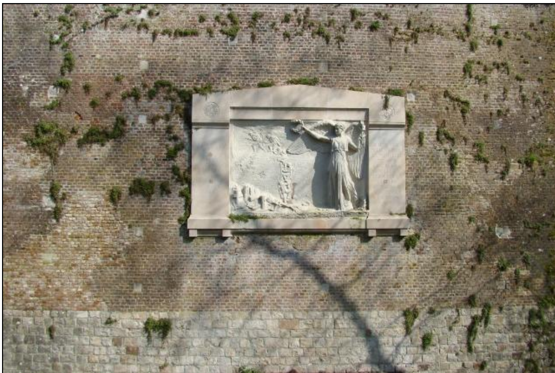
De binnenste stadsmuur van Le Quesnoy met het Nieuw-Zeelands monument.
